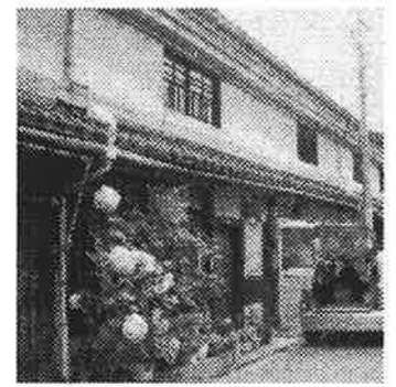
長屋のひとつが鋼工場の倉庫として使われています
