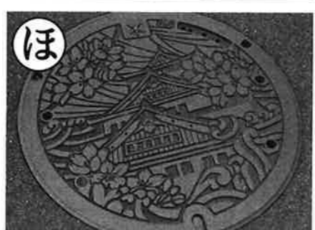
◀マンホール下水道の蓋が...大阪城です。
